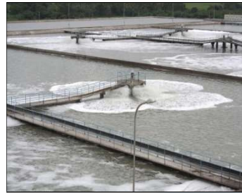
172 MLD STP, Hyderabad, TS
