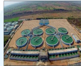
410 MLD WTP, Nalgonda, TS
